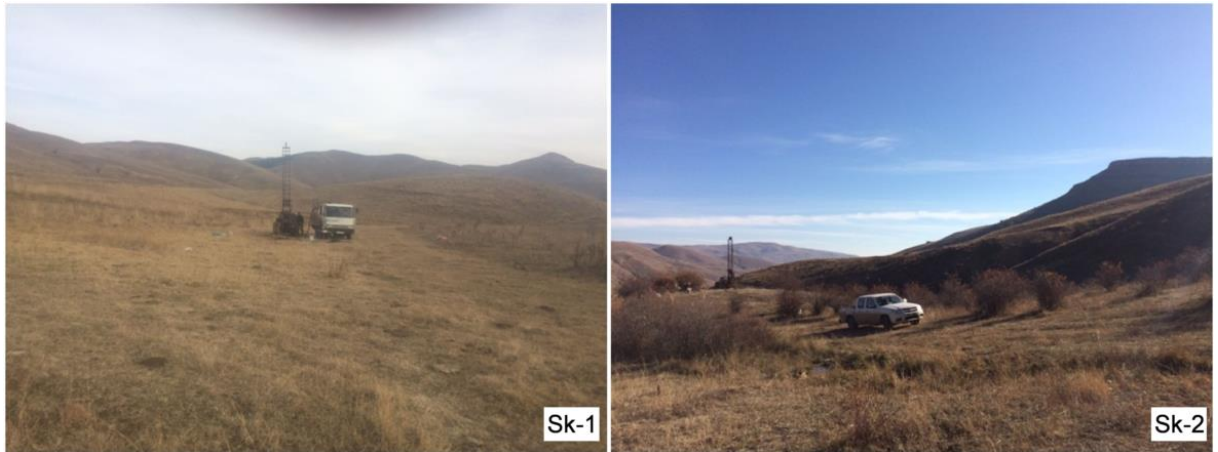
Şekil 61. Yenice'de (Gümüşhane) yapılan sondaj çalışmalarına ait arazi fotoğrafları
