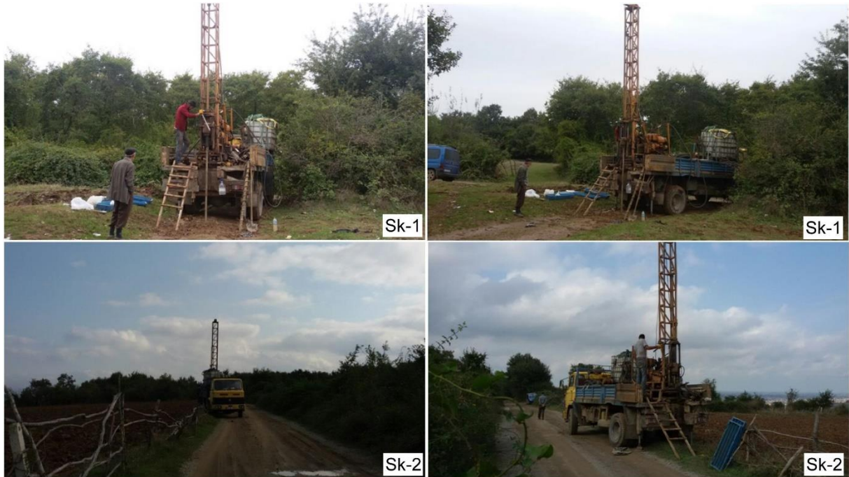
Şekil 33. Bafra ilçesinde (Samsun) sondaj çalışmalarına ait arazi fotoğrafları
