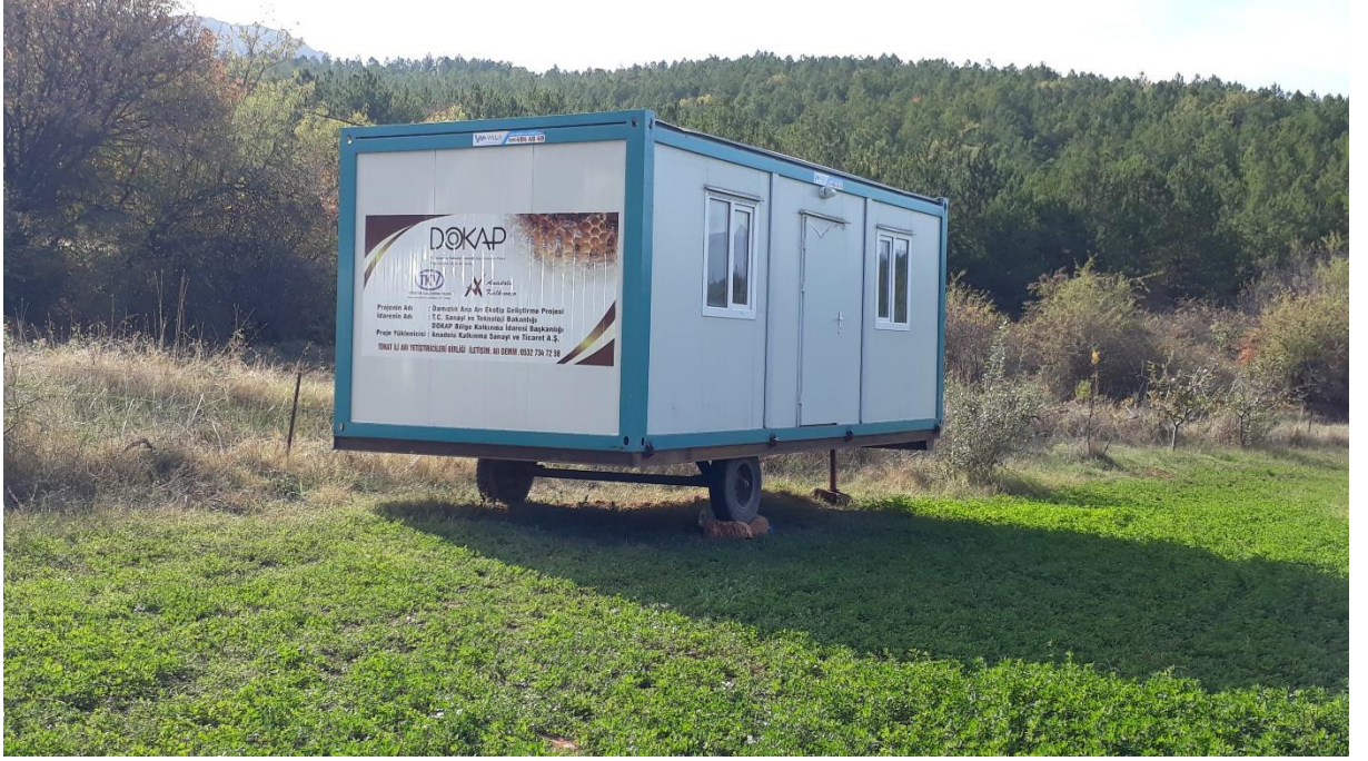
Tokat uygulama merkezi konteyner görünümü
